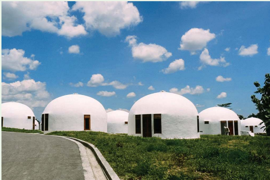
Gambar 1.9 Bangunan tahan gempa Rumah Dome di Sleman, Yogyakarta Sumber: Kania Dekoruma/ dekoruma.com (2018)
