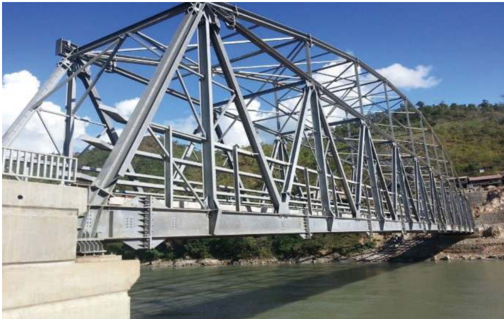
Gambar 3.5 Jembatan baja Sumber: www.ijintender.co.id (2021)
