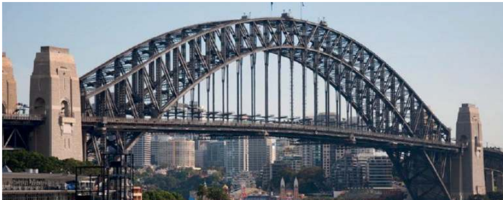
Gambar 3.11 Jembatan lengkung ( arch bridge )
