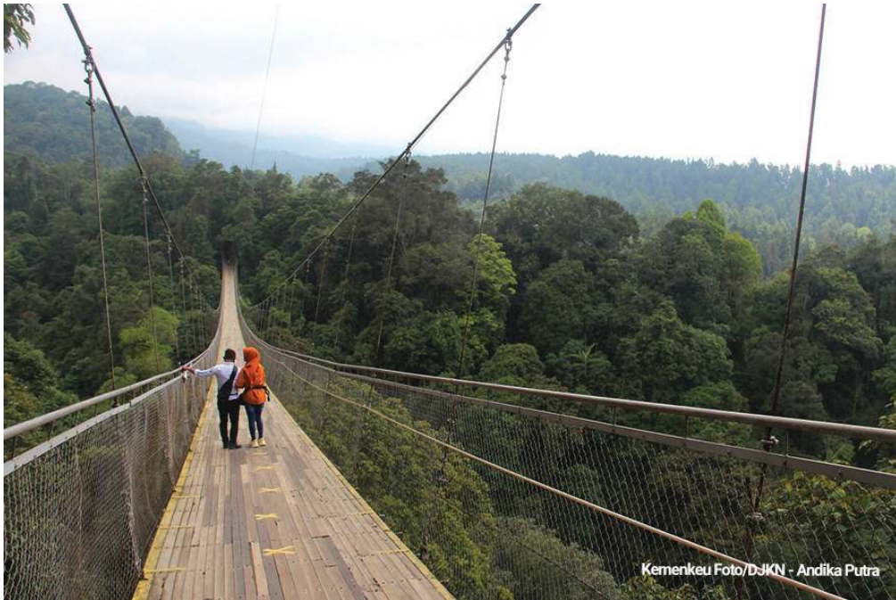
Gambar 3.15 Jembatan Gantung Situ Gunung
