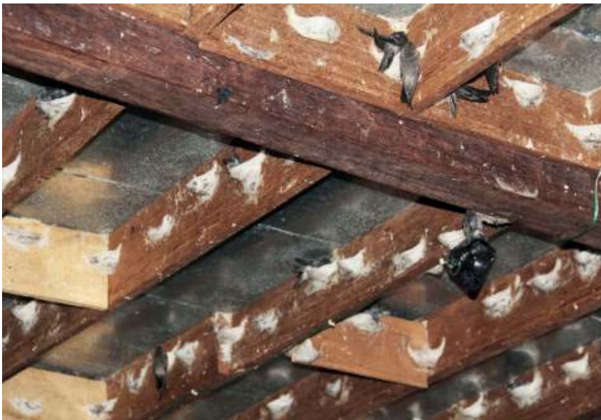
Gambar 2.2 Papan sirip rumah burung walet Sumber: Arief Budiman/ https://duniawalet.co.id (2016)
