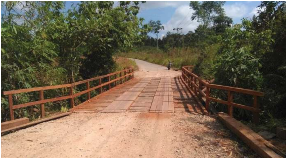
Gambar 3.2 Jembatan kayu Sumber: dpu.kulonprogo.go.id (2022)
