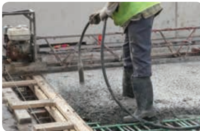
Gambar 2.15 Proses pemadatan beton
