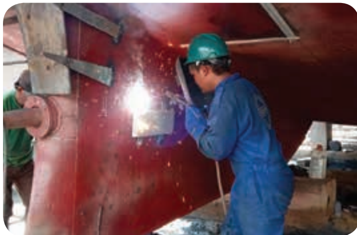
Gambar 1.6 Pengelasan Komponen Konstruksi Kapal Baja
