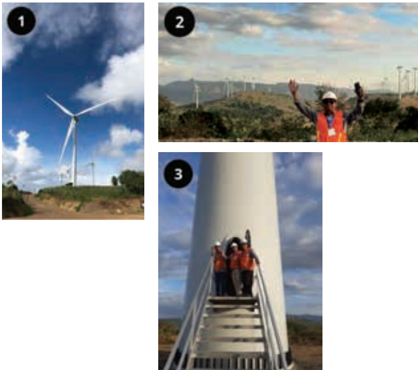
Gambar 1.4 Pembangkit Listrik Tenaga Bayu (PLTB) di Sidrap Makassar
