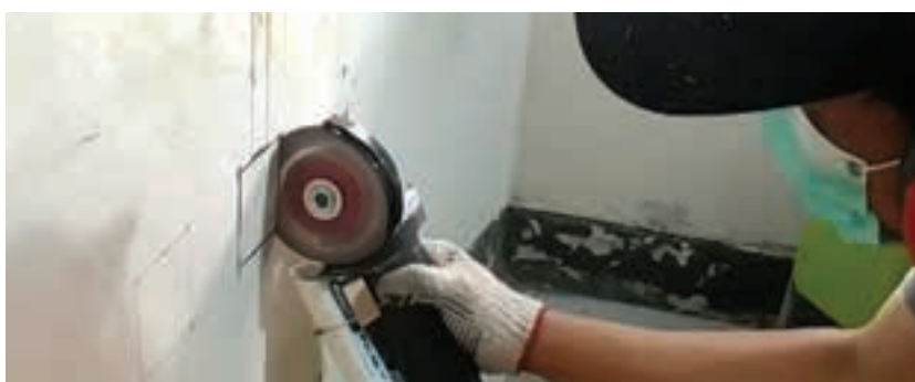
Gambar 4.25 Pekerja Mengiris Tembok Menggunakan Gerinda untuk Membuat Lubang
