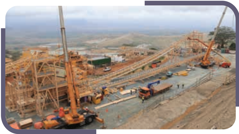
Gambar 1.15 Tahap konstruksi tambang emas dan tembaga di PT Bumi Suksesindo, Banyuwangi-Jawa Timur
