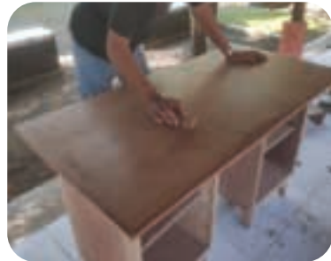
Gambar 4.68 Pengamplasan Permukaan Kayu Sumber: Suradi (2022)
