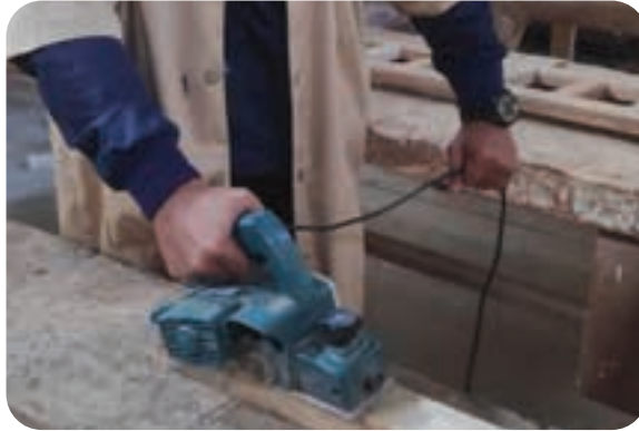
Gambar 4.70 Mengetam dengan ketam tangan listrik Sumber: Suradi (2022)
