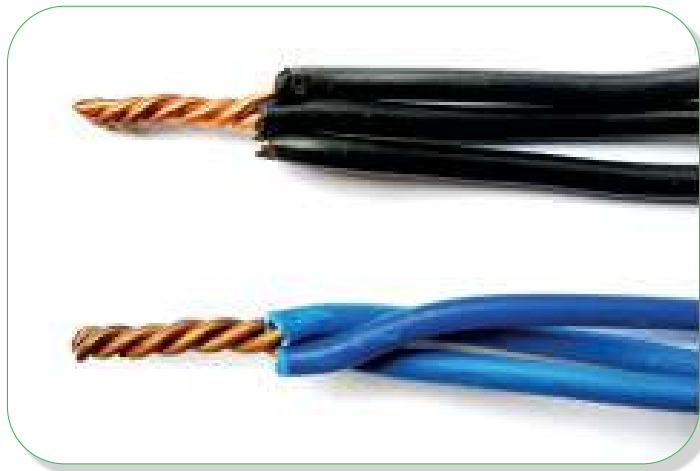
Gambar 1.4 Sambungan Pig Tile pada Kabel Sumber: Wawat N/Kemendikbudristek (2022)
