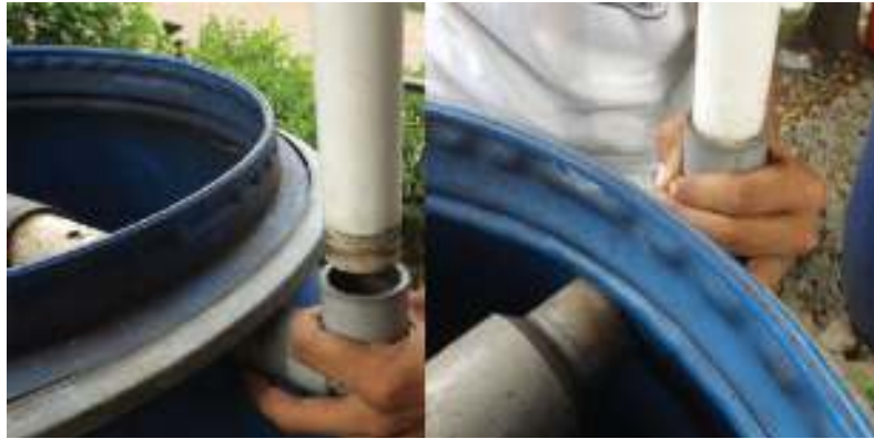
Gambar 6.15 Penyambungan cerobong udara
