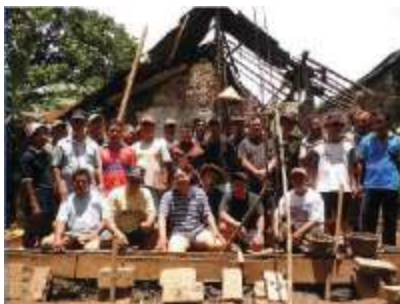
Sumber: Dokumen Kemdikbud Gambar 6.2 Warga bergotong royong memperbaiki rumah yang rusak
