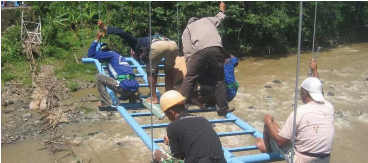
Gambar 5.1 Gotong royong membangun jembatan di suatu daerah menjadi ciri khas bangsa Indonesia
