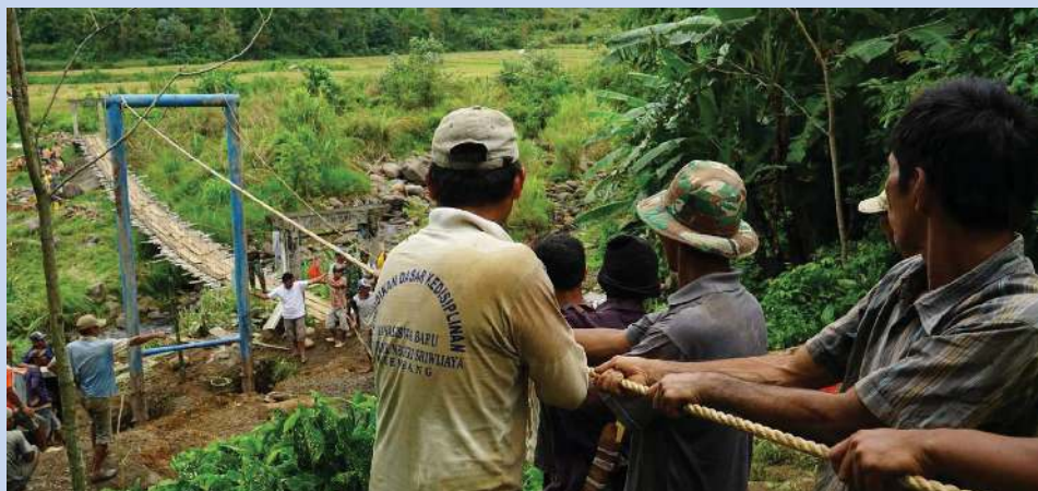
Gambar 5.15 Gotong Royong membangun jembatan
