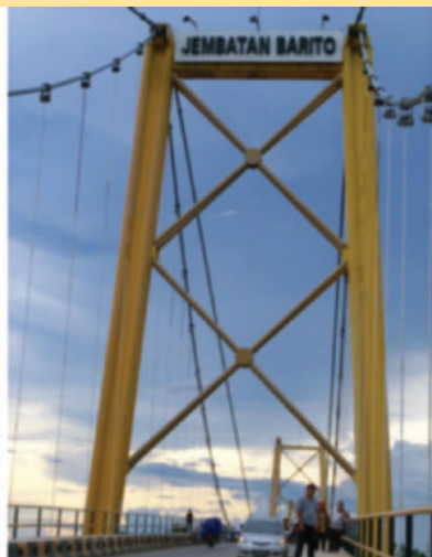
(ii) Jembatan Barito
