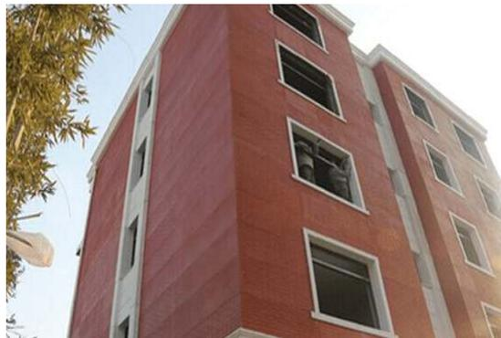
Gambar 1.6 Gedung tertinggi yang dibangun dengan *3D printing*
