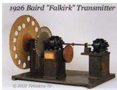
Kemudian disekitar tahun 1920, para pakar lainnya seperti John Logie Baird dan Charles Francis Jenkins, menggunakan piringan Nipkow ini untuk menciptakan suatu sistem dalam penangkapan gambar, transmisi, dan penerimaannya. Mereka membuat seluruh sistem televisi ini berdasarkan sistem gerakan mekanik, baik dalam penyiaran maupun penerimaannya. Saat itu belum ditemukan Cathode Ray Tube [CRT].
