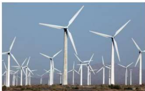
Gambar 5 Pembangkit Listrik Tenaga Angin
