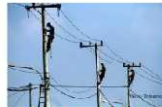
Trafo Step Down pada Tiang Listrik
