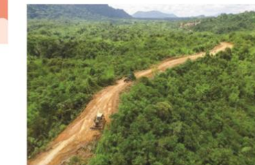
Sumber : finance.detik.com Gambar 6.8 Pembangunan jalan di perbatasan Indonesia - Malaysia di Kalimantan, untuk mendukung kemajuan daerah.
