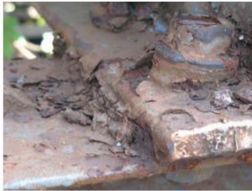
Gambar 7. Keberadaan pengotor mempercepat korosi logam (Sumber: Fadillah, 2020 )
