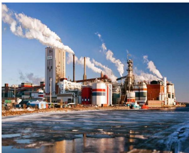
Gambar 4. Gambar Pabrik Industri Sumber : arsitag.com
