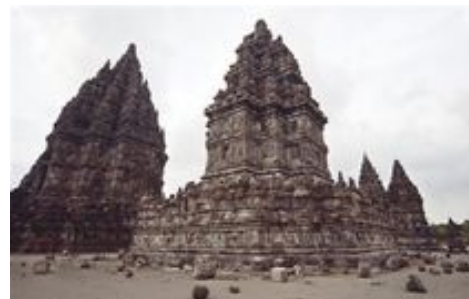
Gambar 9.8 Candi Prambanan Runtuh Akibat Gempa
