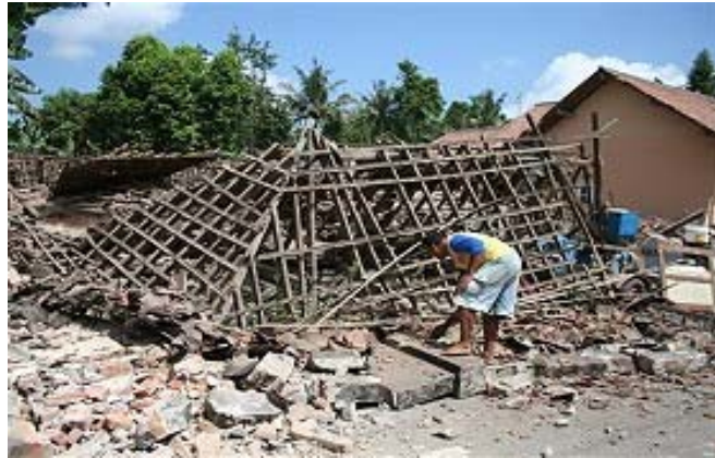
Gambar 9.7 Rumah Roboh Akibat Gempa di Yogyakarta
