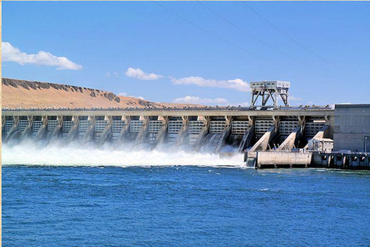
Pembangkit Listrik Tenaga Air (PLTA)
