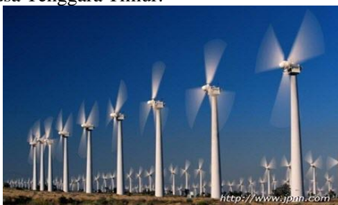
Pembangkit Listrik Tenaga Angin
